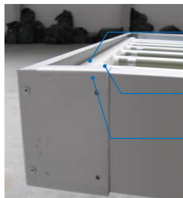
Abb. 17: Endbox aufschieben
