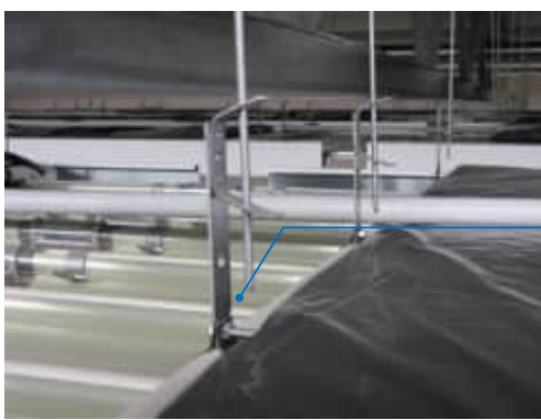
Abb. 23: DSP an Abhängiger montieren
