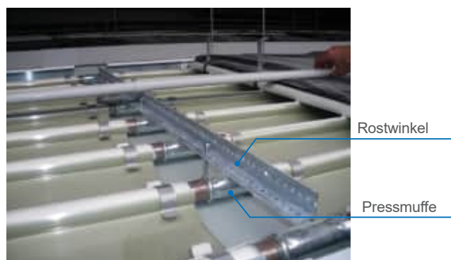
Abb. 38: Rostwinkel für Abdeckblech aufsetzen
