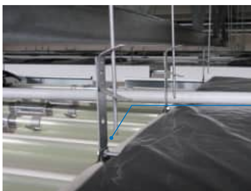
Abb. 23: DSP an Abhänger montieren
