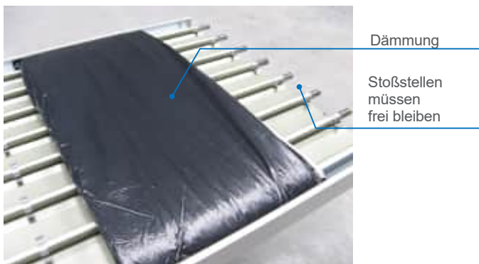
Abb. 20: Dämmung einlegen
