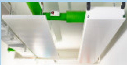
SMARTLINE-Segel (li.) und COOLLINE-Kühlkonvektor (re.)
