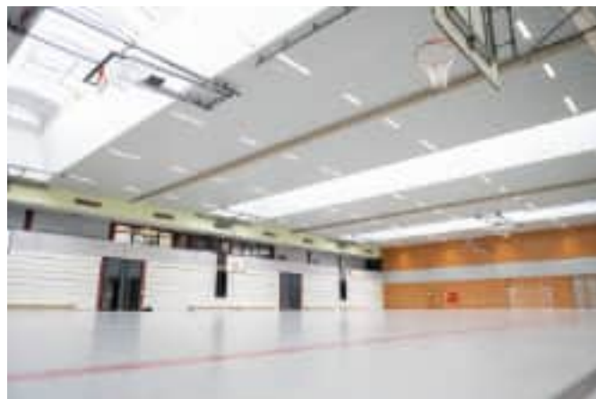
Heizung, Kühlung, Licht, Akustik und Optik in einem Deckensystem
