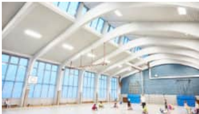
Strahlungswärme sorgt für einen wohltemperierten Fußboden
