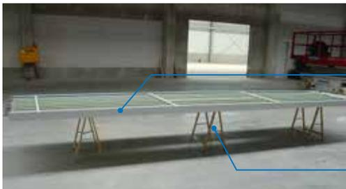
DSP mit der Unterseite auf eine geeignete Arbeitsunterlage legen.
