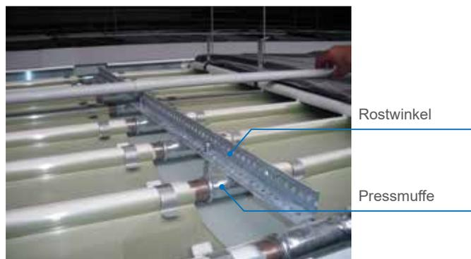
Abb. 38: Rostwinkel für Abdeckblech aufsetzen
