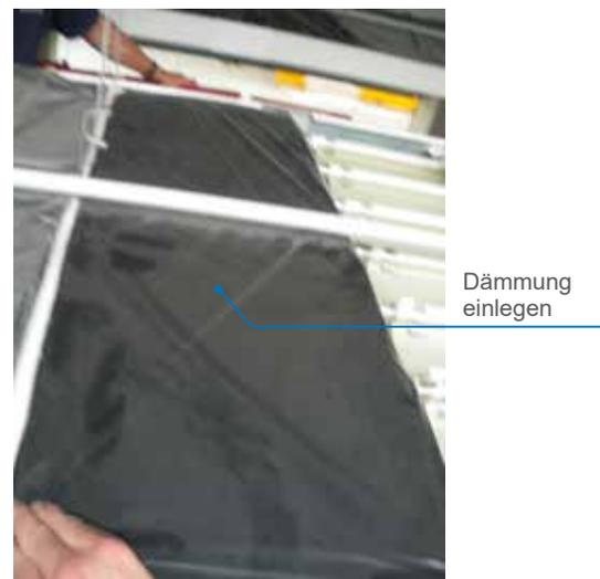
Abb. 42: Dämmung einlegen
