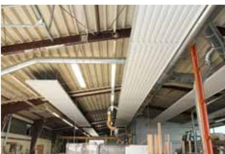
*Vor (li.) und nach (re.) der Sanierung: Trotz zahlreicher Hindernisse an der Decke erfolgte die Montage der neuen Strahlplatten im geplanten Zeitrahmen.*
