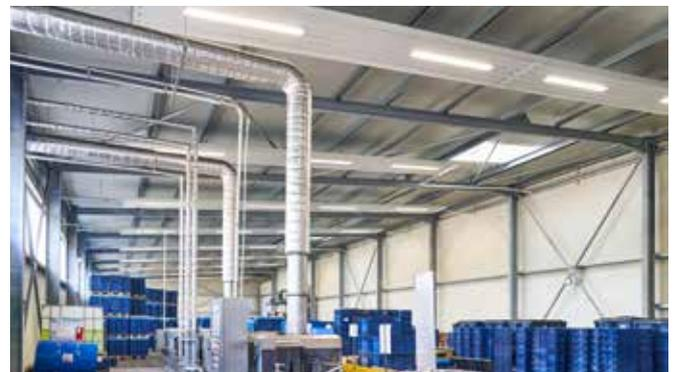
Abb.: Deckenstrahlplatten mit integrierter LED-Beleuchtung in Technikhalle mit hoher Maschinenabwärme
