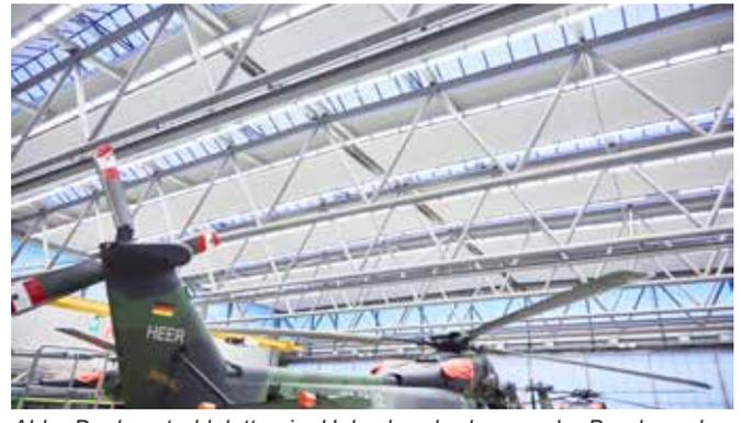
Abb.: Deckenstrahlplatten im Hubschrauberhangar der Bundeswehr
