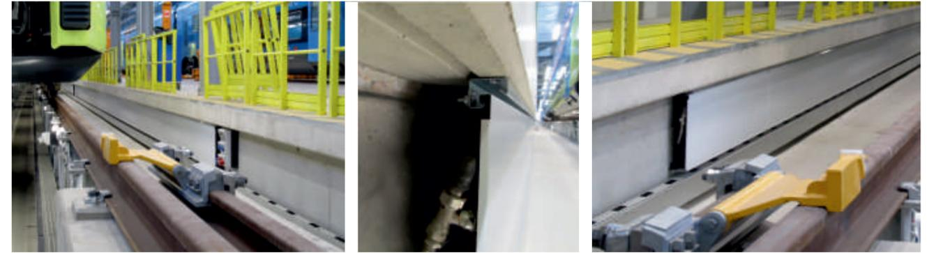
Komfortable und effiziente Beheizung der Arbeitsgruben unter dem Gleiswerk mit PITLINE-Heizsegel von FRENGER
