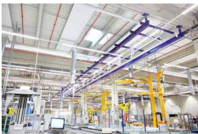
Der erhöhte Strahlungsanteil der verbauten Deckenstrahlplatten von über 80 Prozent gegenüber marktüblichen Systemen führt hierbei zu einem besonders hohen Wirkungsgrad und damit zu ca. 15 Prozent niedrigerem Energieverbrauch im Heizbetrieb. Erreicht wird dies durch konstruktive Weiterentwicklungen und eine wannenartige Form der Deckenstrahlplatten. Diese senkt die konvektive Abgabe von
