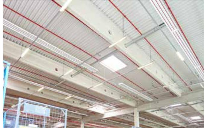
In der 6.600 qm großen Logistikhalle sind Deckenstrahlplatten mit einer Breite von jeweils 460 mm eingebaut.
