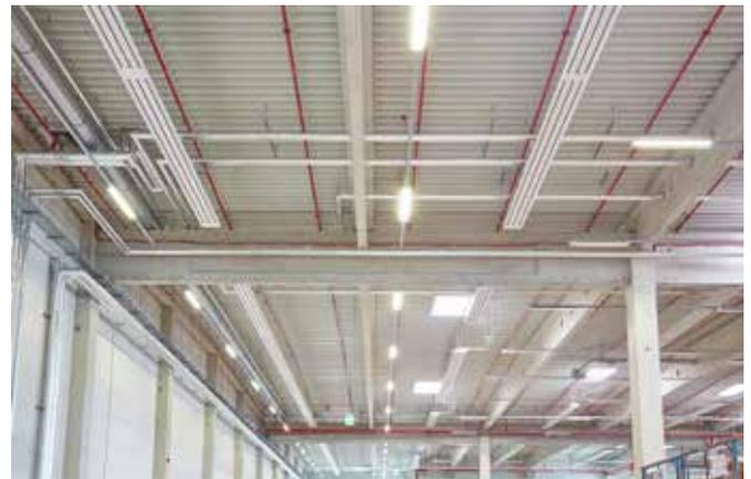
Insgesamt 45 Frenger-Deckenstrahlplatten mit einer Gesamtfläche von 345 qm sind hier gleichmäßig installiert..
