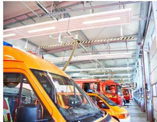
Die Heizleistung wird mit einer Vorlauftemperatur von 65° C und einer Rücklauftemperatur von 45° C bei einer Raumtemperatur von 18° C angesetzt. Die gesamte Wärmeleistung der Deckenstrahlplatten beträgt rund 58 kW.
