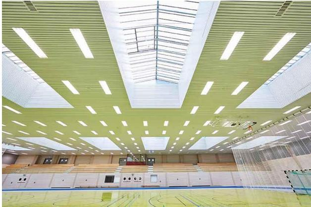
BU: Gut 2.400 qm ist die Barbarosahalle in Kaiserslautern groß. Die ballwurfsichere Paneeldeckenstrahlheizung des Frenger-Typs S85 mit LED-Beleuchtung heizt und kühlt hier höchst effizient.
