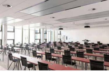
bereich von 250 Hz bis 4.000 Hz Schall absorbiert wird. Die Schallenergie dringt in das perforierte Deckensegel, dadurch wird Reibung in Wärme umgewandelt und absorbiert. So wird einfach die Akustik und die Nachhallzeit verbessert - trotz der Baukonstruktion aus dominierendem Stahlbeton und Glas.
