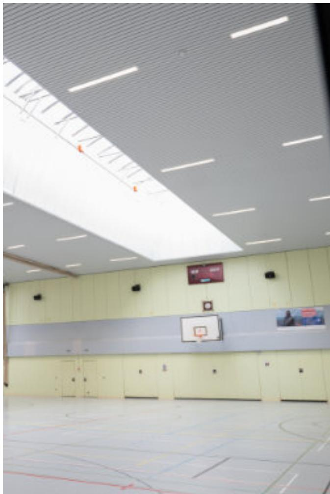
Ballwurfsichere Systemeinbauleuchte, integriert in Paneeldeckenstrahlungsheizung A-85/S-85
