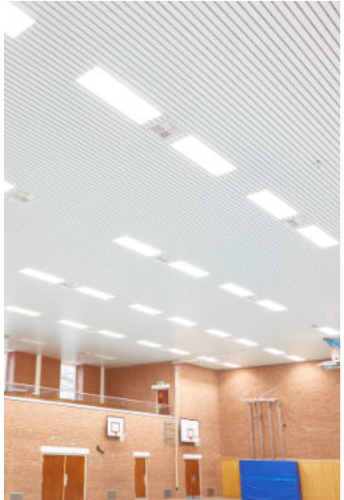
Ballwurfsichere Systemeinbauleuchte, integriert in Paneeldeckenstrahlungsheizung A-85/S-85
