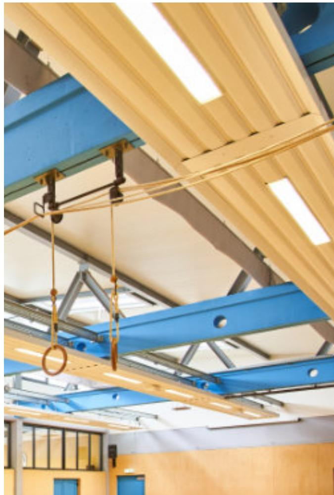
Ballwurfsichere Systemeinbauleuchte, integriert in Deckenstrahlplatte HB 150 ECO EVO Plus
